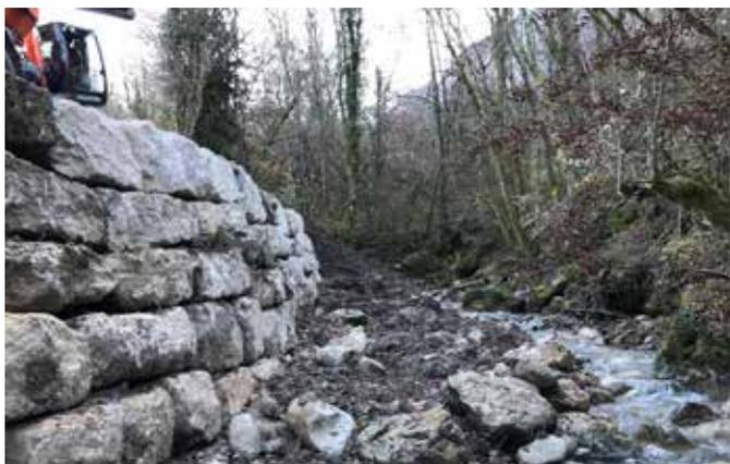
Les travaux de consolidation de la berge, du chemin rural dit «de Marceau à Saury», en prolongement de la route de la Bornette, avec la création d'un enrochement libre sur 16 ml, permettront de stabiliser le chemin.
