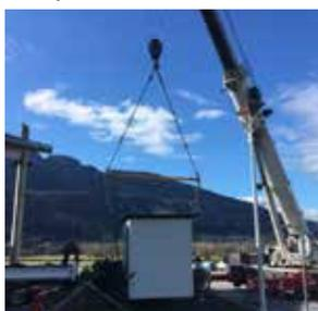
L'installation de sanitaires autonettoyants a nécessité l'amené des réseaux électriques, eaux usées et eau potable, et la création d'une plate-forme.
